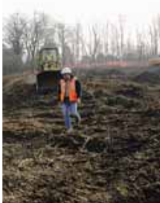
Un cantiere di Pedemontana
